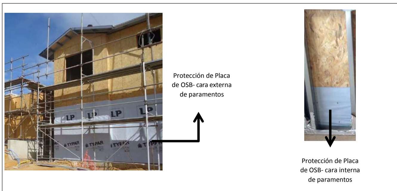
Figura 12 – Protección de Placas de OSB con Barrera Humídica y Permeable al vapor de agua.
