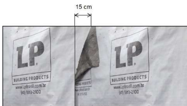
Figura 2 - Esquema de solapado de barrera impermeable al agua y permeable al vapor de agua
